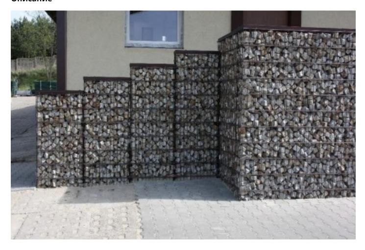
Сварные габионы – строительный и декоративный материал, отличающийся от обычных габионных изделий тем, что ячейки в них не просто сплетаются меж собой, а точечно свариваются. Проволока сетки защищена цинковым покрытием, нанесенным с глубокой агдезией, что обеспечивает долговечность ее службы в условиях воздействия разрушающих атмосферных факторов.
